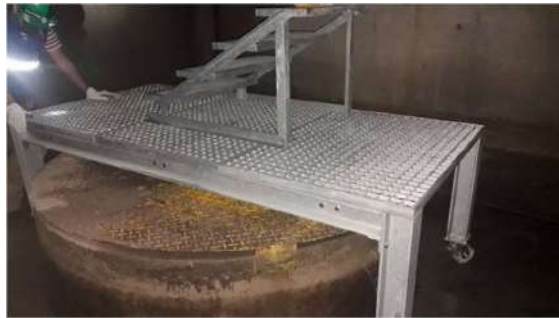
Plataforma de desplazamiento
