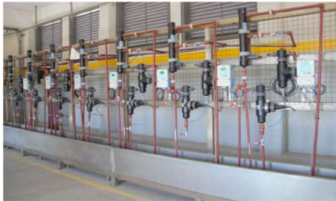
Readecuación SMCC filtrada PJMR
