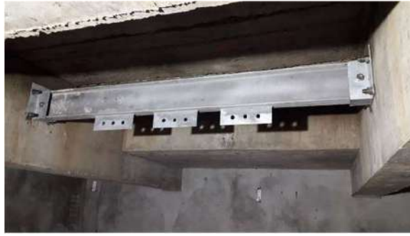
Viga de Izaje
