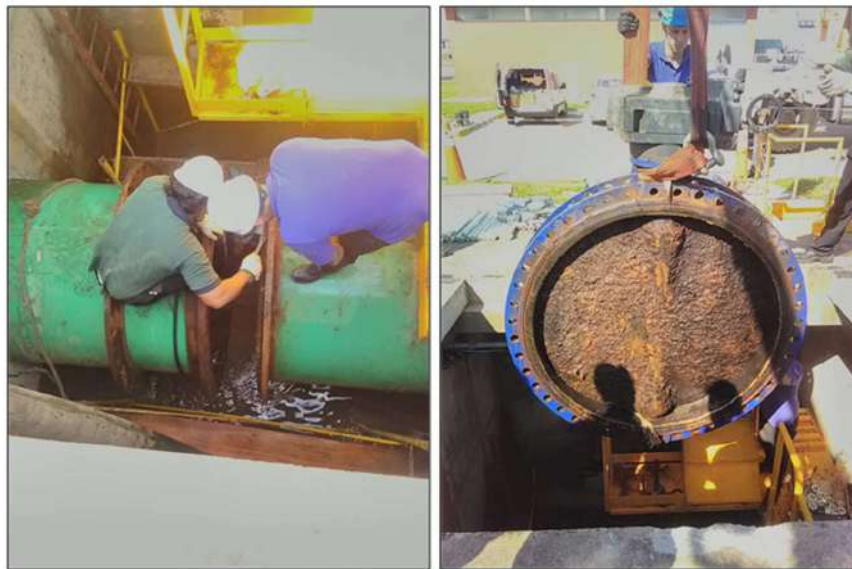
Desmontaje de la válvula de ingreso al Módulo
