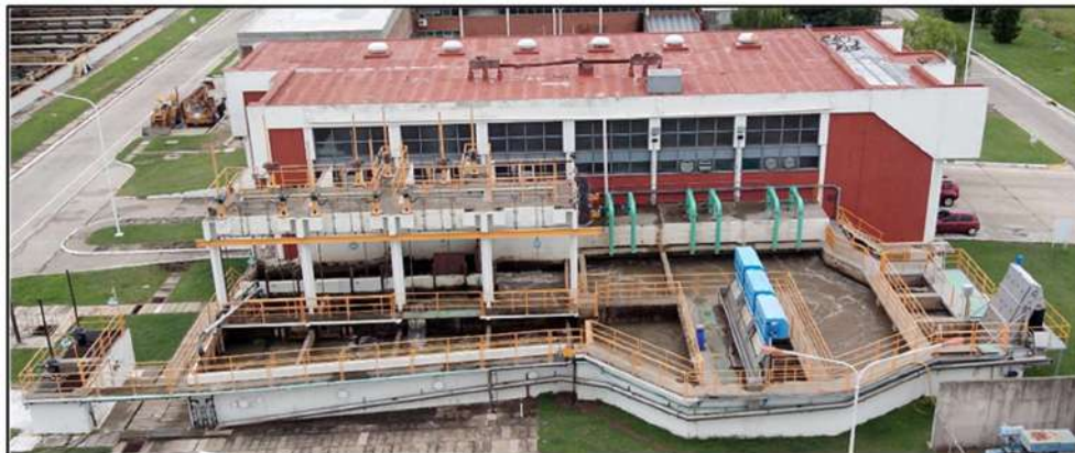
Cámara de Carga de Agua Cruda
