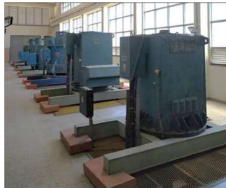
Estación Elevadora de Agua Cruda
