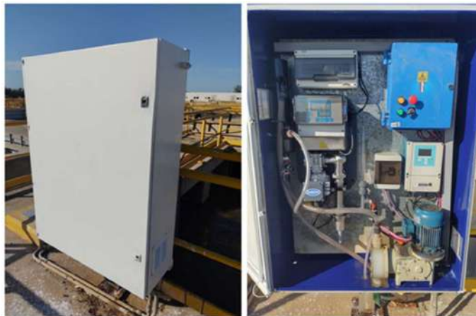
Readecuación SMCC C+C PJMR
