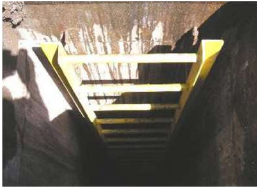
Escalera de acceso
