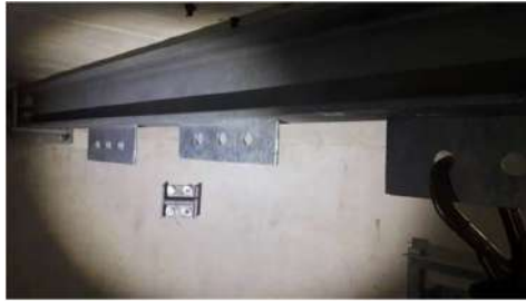
Viga de izaje
