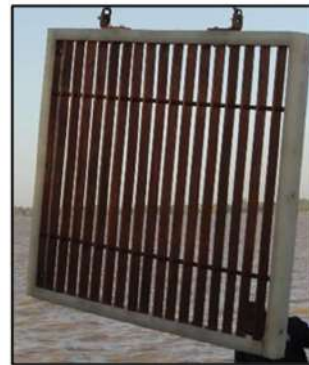
Rejas de Torre Toma
