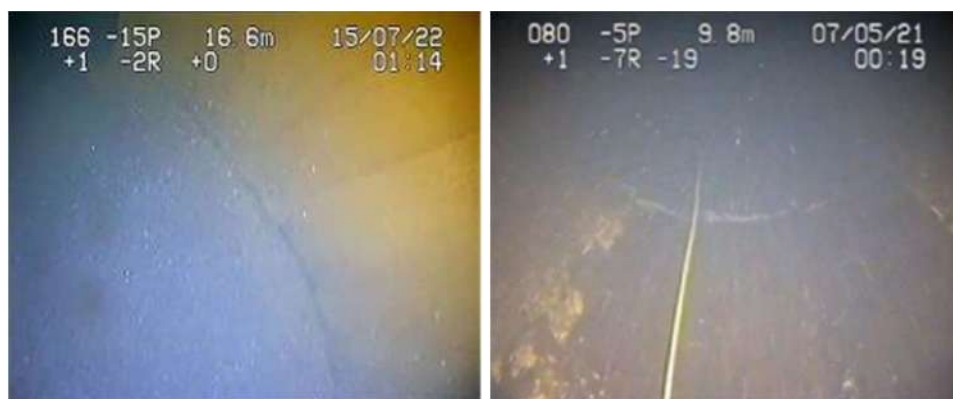
Imágenes del conducto durante las inspecciones
