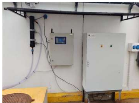
Instalación SMCC en gabinete en AMBA
