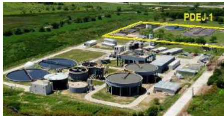
Vista aérea de la Planta El Jagüel I y el Jagüel II
