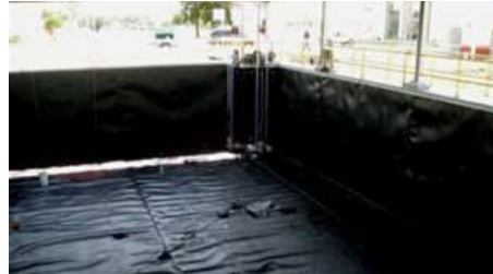
Piletón de sulfato de aluminio.
