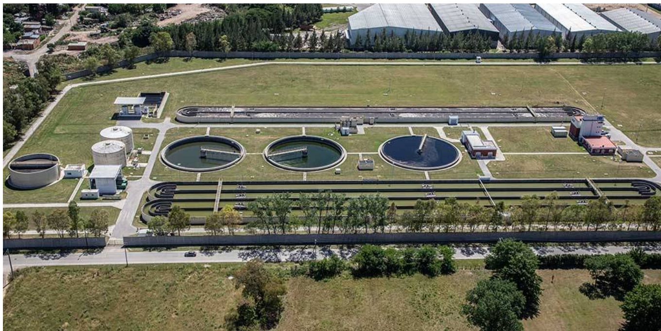
Imagen 27: Foto aérea Planta las Catonas
