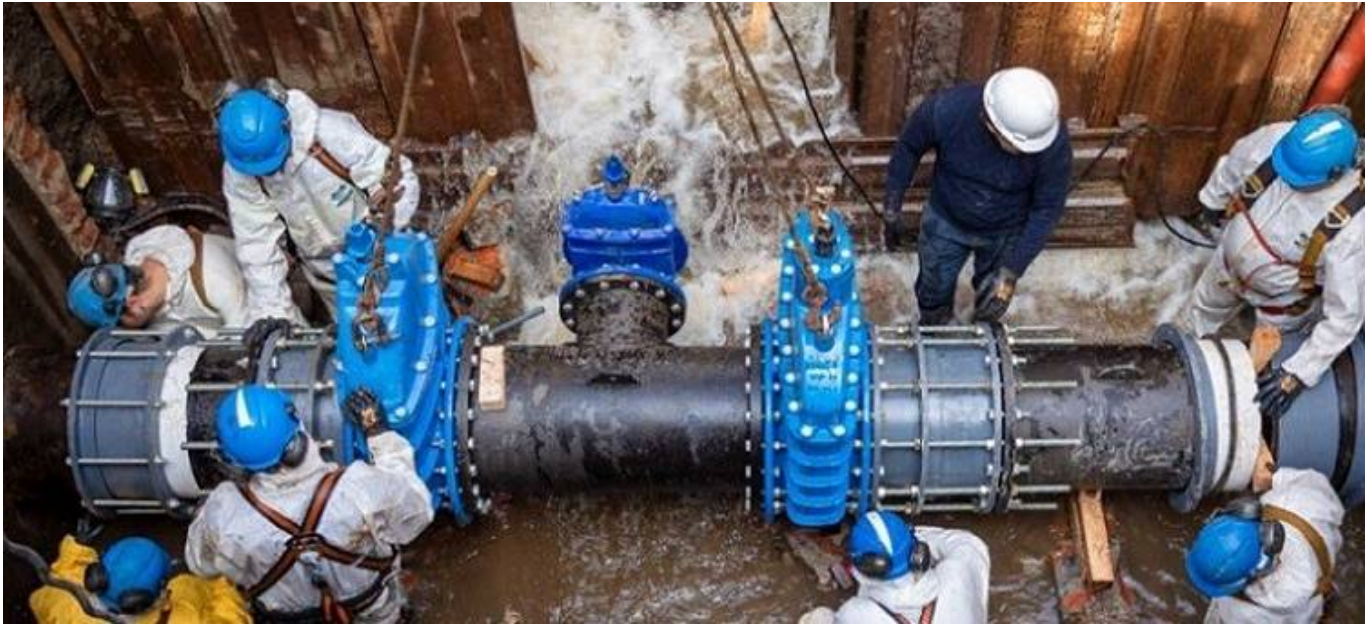
Imagen 10: Intervención en Grandes Conductos de Agua
