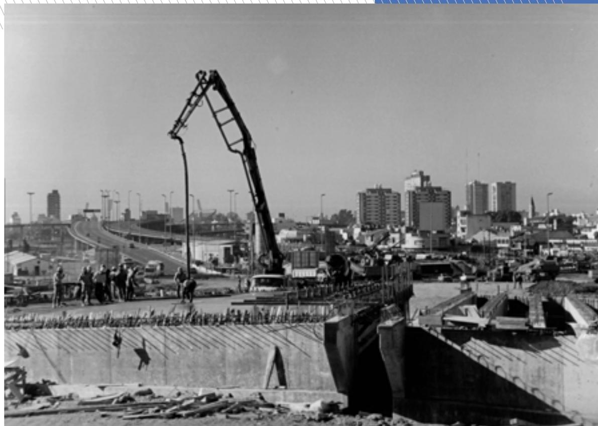
*Obreros alisando el pavimento en la construcción del Distribuidor Acceso Oeste - Av. General Paz - Au. Perito Moreno, Junio de 1997. Roggio Construcción Acceso Oeste, Informe Fotográfico.*
