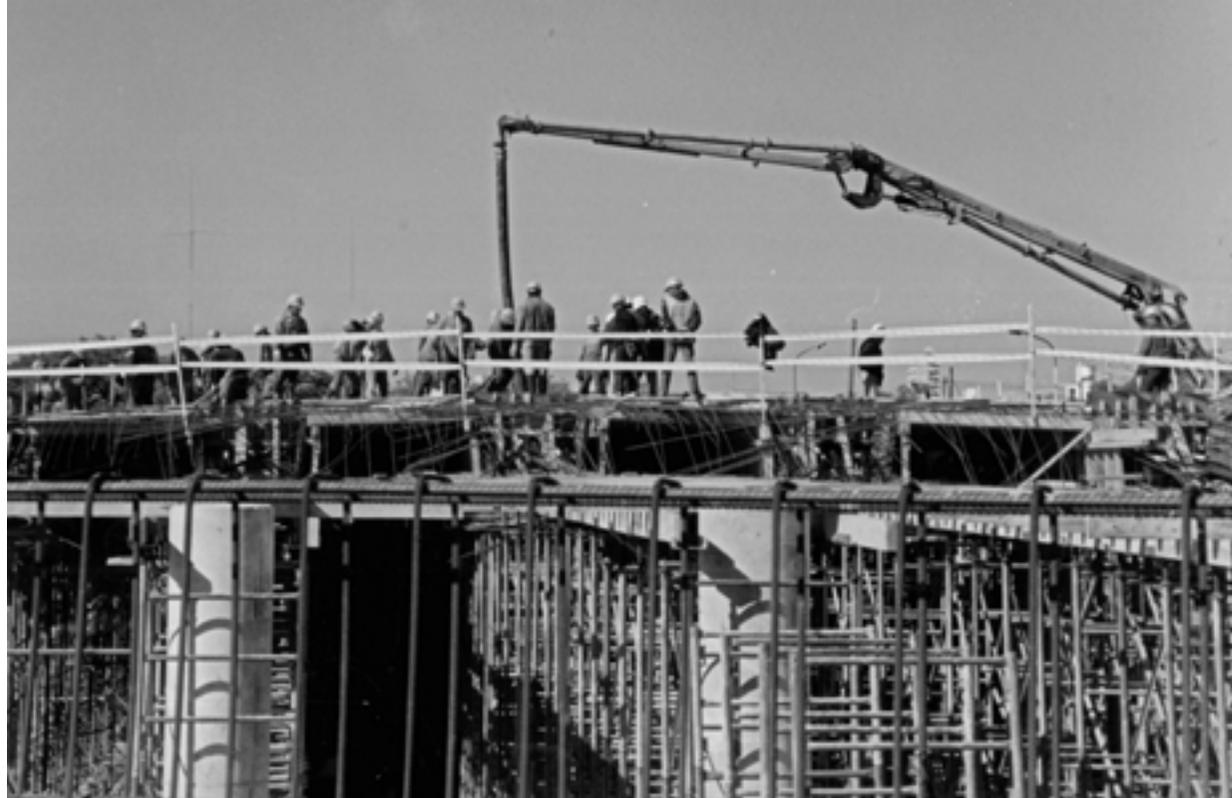
Obreros en la construcción del Acceso Oeste, hormigonado del Puente Comesaña Este, Octubre de 1997. Roggio Construcción Acceso Oeste, Informe Fotográfico.
