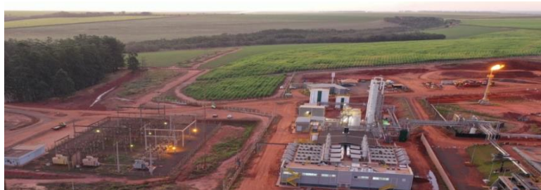
FG163: Vista general de la digestión anaeróbica de Raízen Geo Biogás
