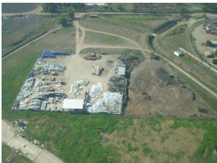
FG96: Predio de concentración y clasificación de residuos
