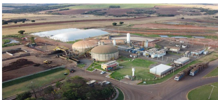
FG164: Vista general de la digestión anaeróbica de Geo Eléctrica Tamboara
