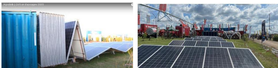
FG156: Sustitución de diesel por alternativa fotovoltaica para electrificación pozos
