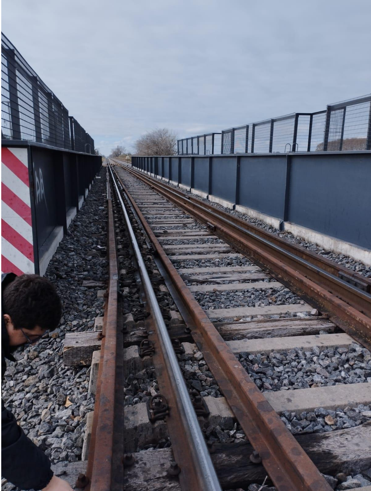
Figura 13 Conjunto rieles, durmientes de hormigón, durmientes de madera, balasto y encarriladores.
