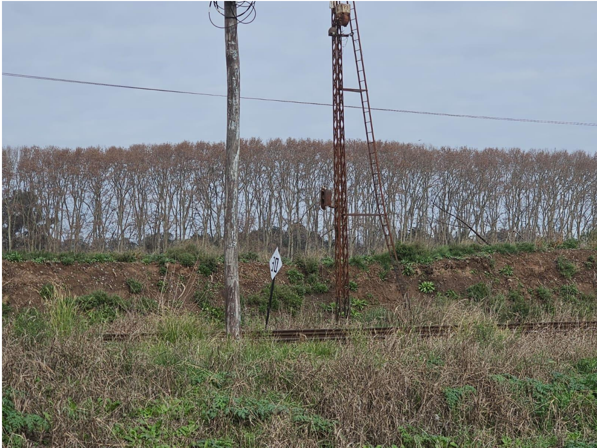
Figura 19 Señal de 30 kilómetros por hora en ingreso al puente de Luján, vía ascendente. Fuente: JST
