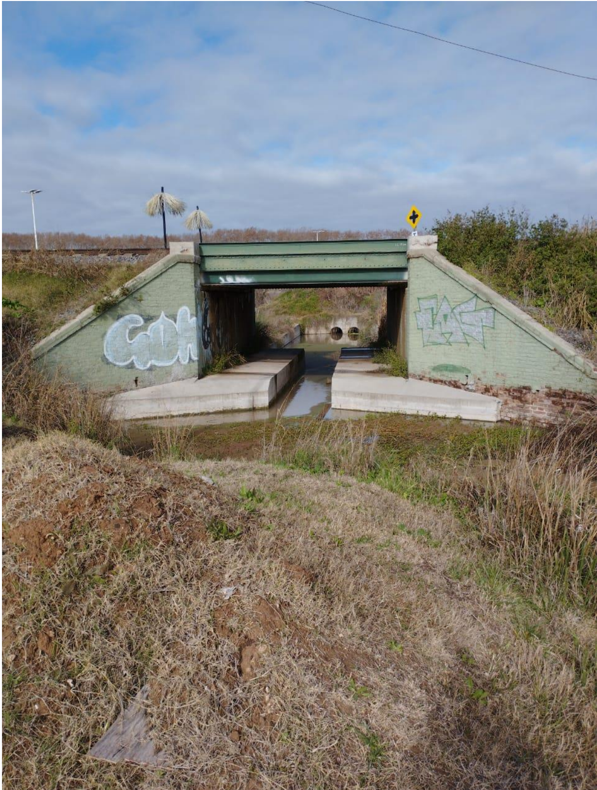
Figura 17 Alcantarilla. Fuente: JST
