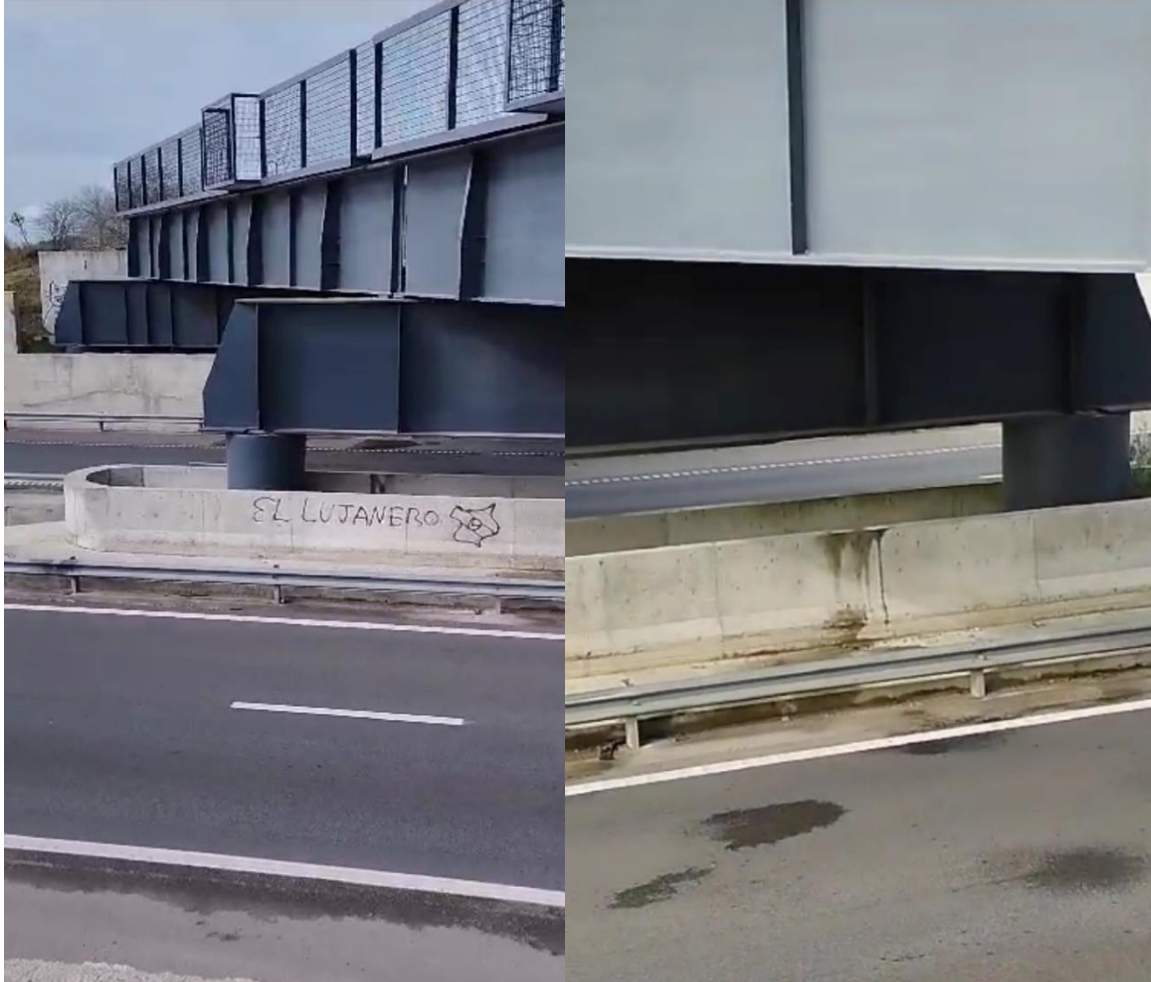
Figura 4 Pilares centrales. Fuente JST
