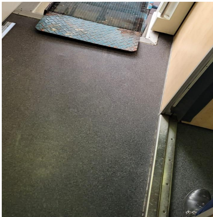
Figura 9. Sobre nivel presente en el marco de la puerta del salón de pasajeros. Fuente: JST, 2023.
