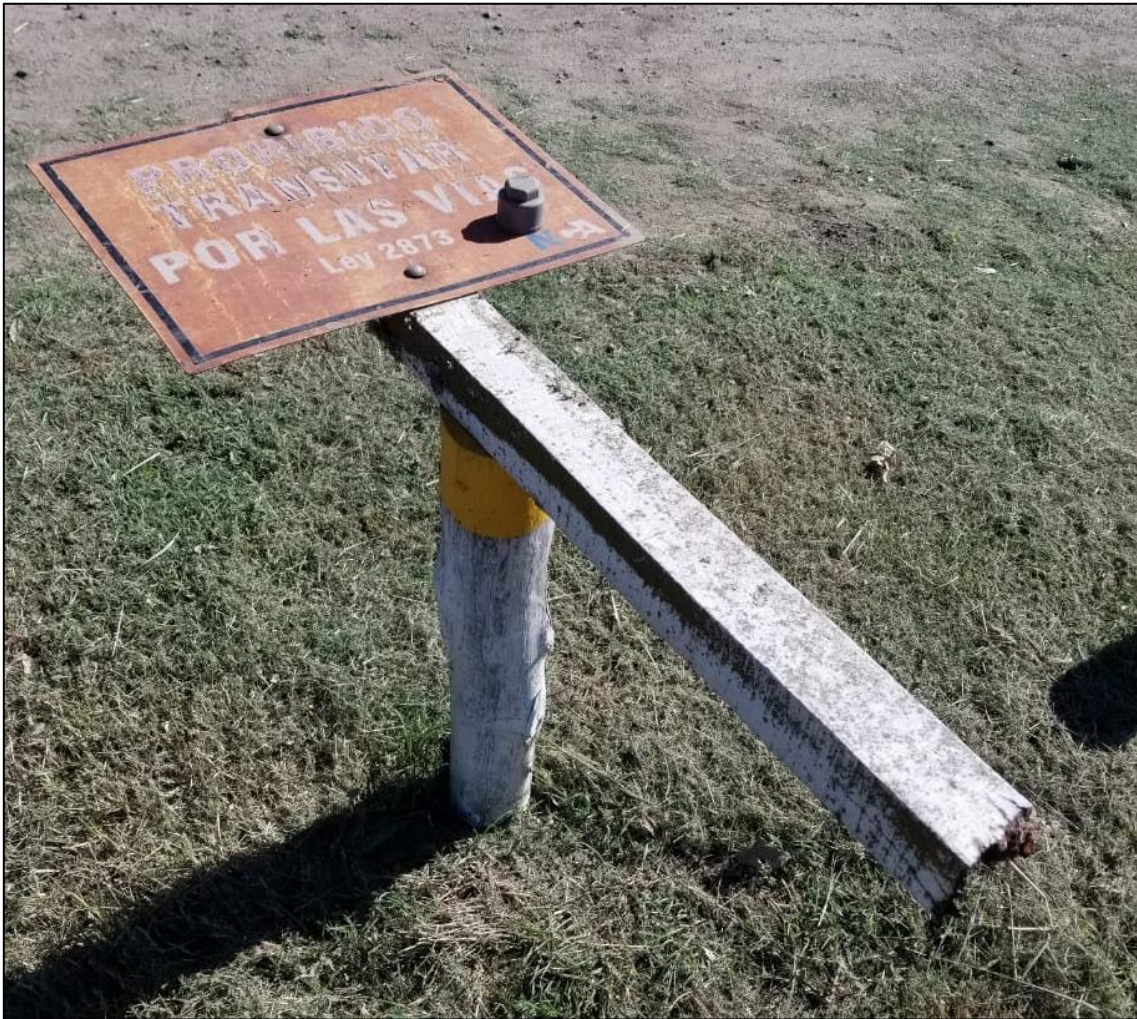
Figura 16. Cartel de “Prohibido el Transitar por las Vías” con daños en su estructura.
