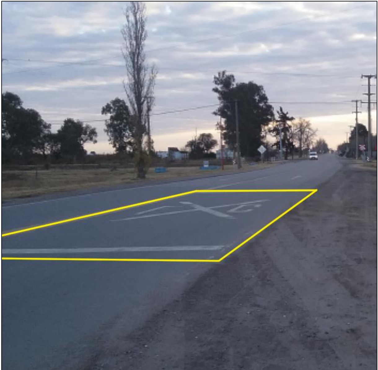
Figura 7. Presencia señal H13 en el ingreso a Cintra. Fuente: JST, 2024
