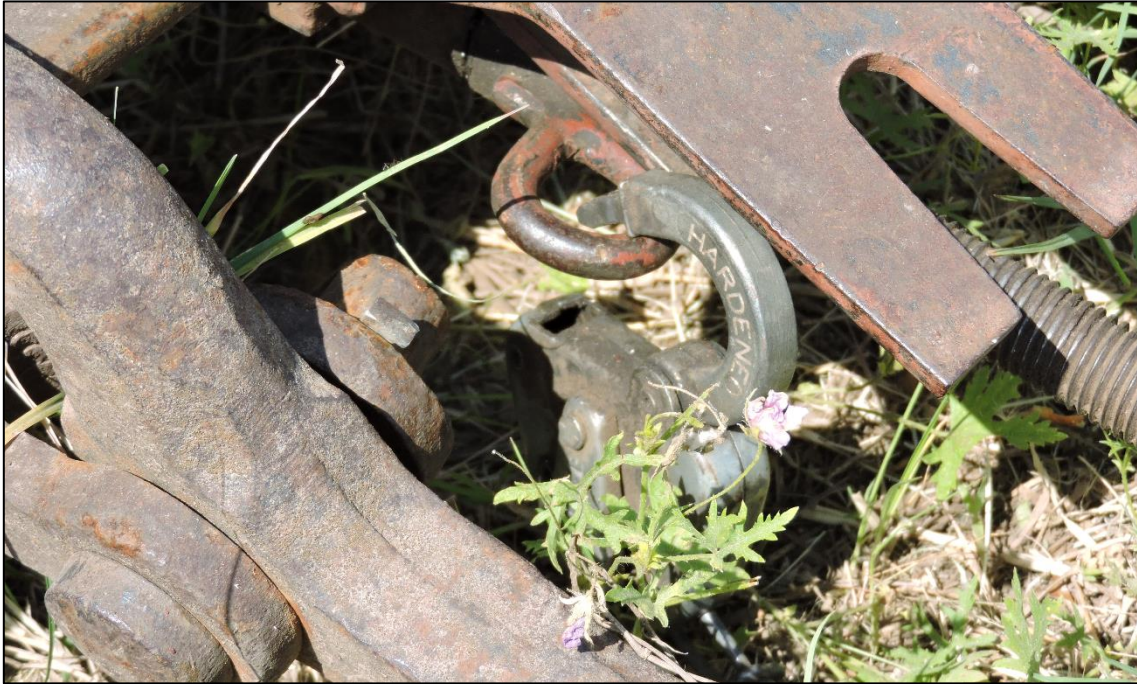
Figura 18. Candado de cambio de vía abierto identificado durante el relevamiento de noviembre de 2023. Fuente: JST, 2023
