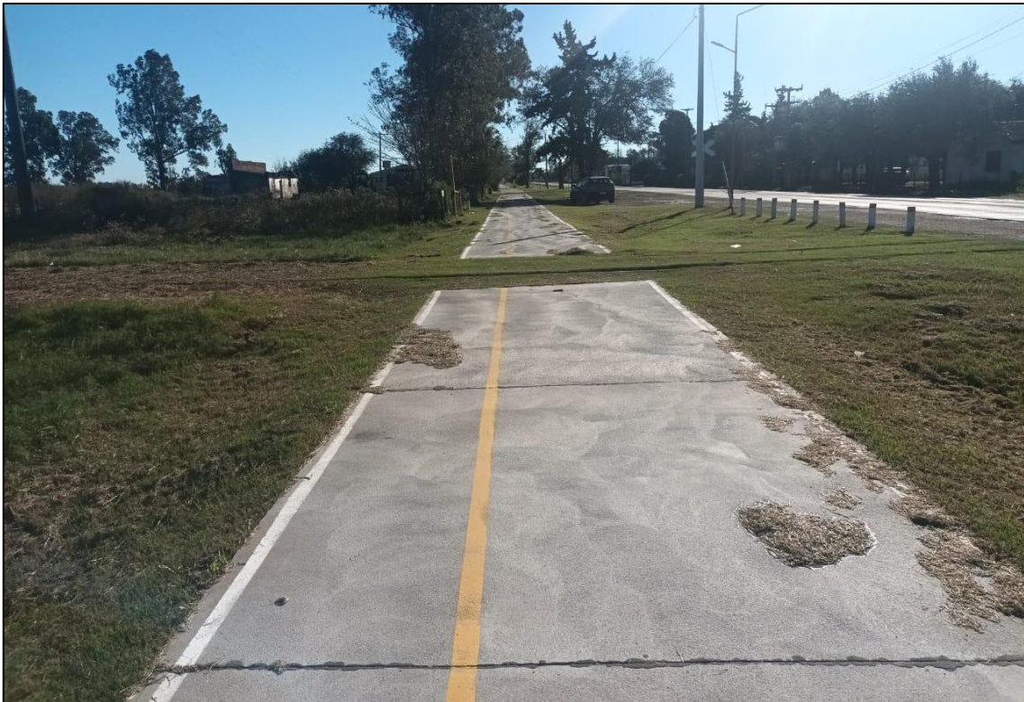
Figura 13. Avances de la obra con la incorporación de líneas de demarcación horizontal.
