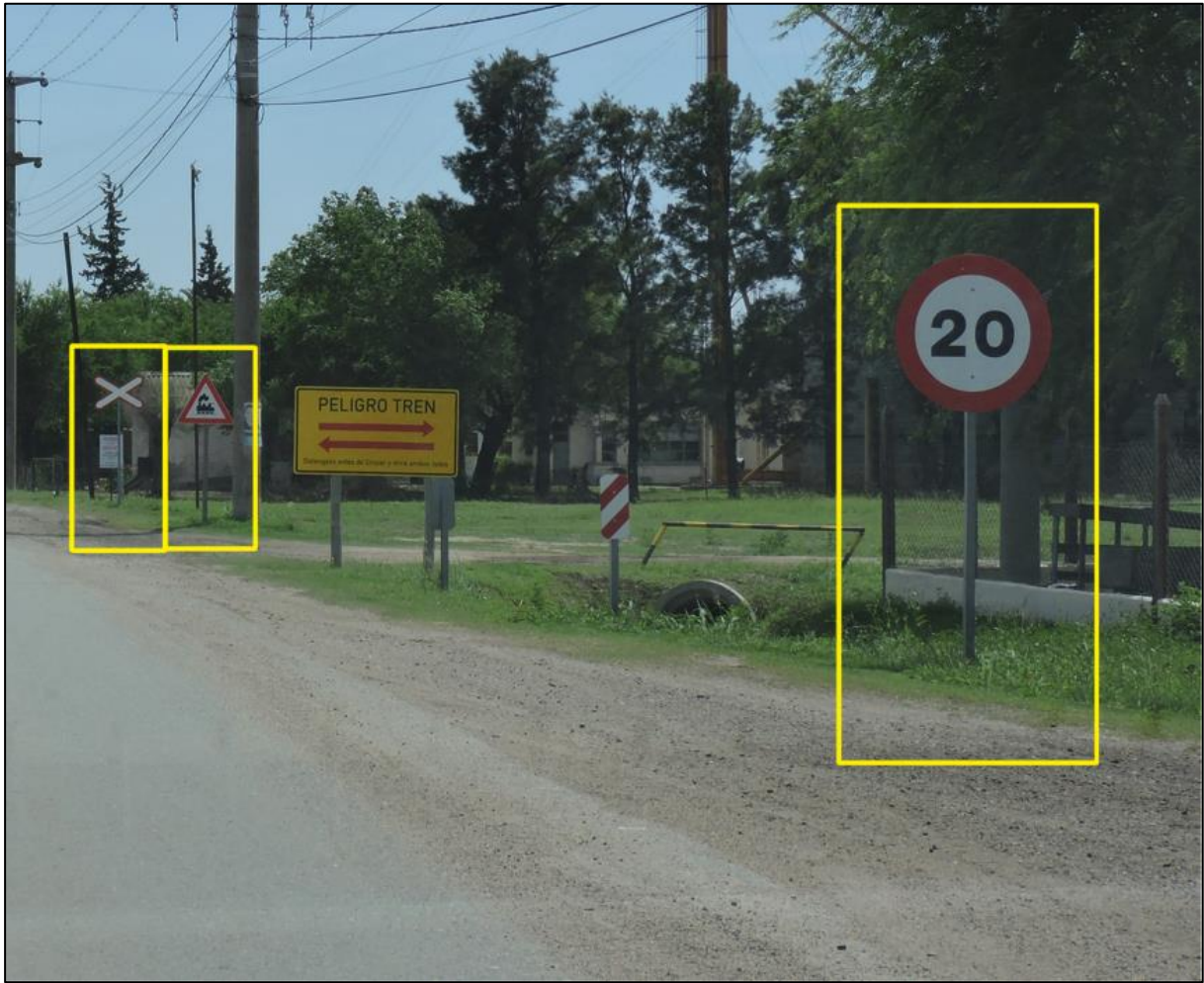
Figura 1. Presencia de las señales P1, R15, P3 y ausencia de señal R8 en el ingreso a Cintra.
