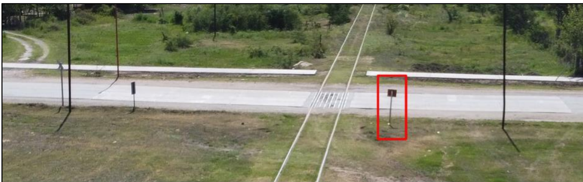
Figura 17. Vista del cartel durante el relevamiento de noviembre de 2023. Fuente: JST, 2023
