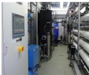
Todo el proceso está controlado por un PLC y se ha de disponer de un panel táctil para la operación del equipo con un programa SCADA que permita el control y operación del equipo, así como la visualización y el registro de los datos de operación.
