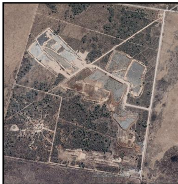
Figura 61 – Imagen del estado actual del sitio de implantación del Centro Ambiental Santiago del Estero
