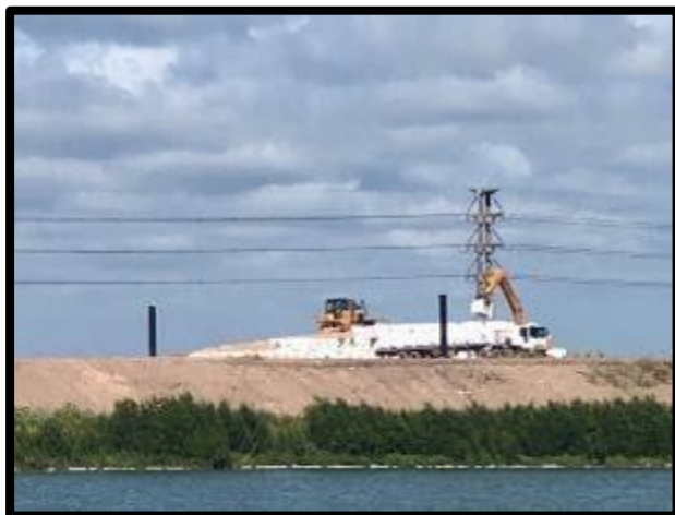
Figura 10. Relleno de Balas
