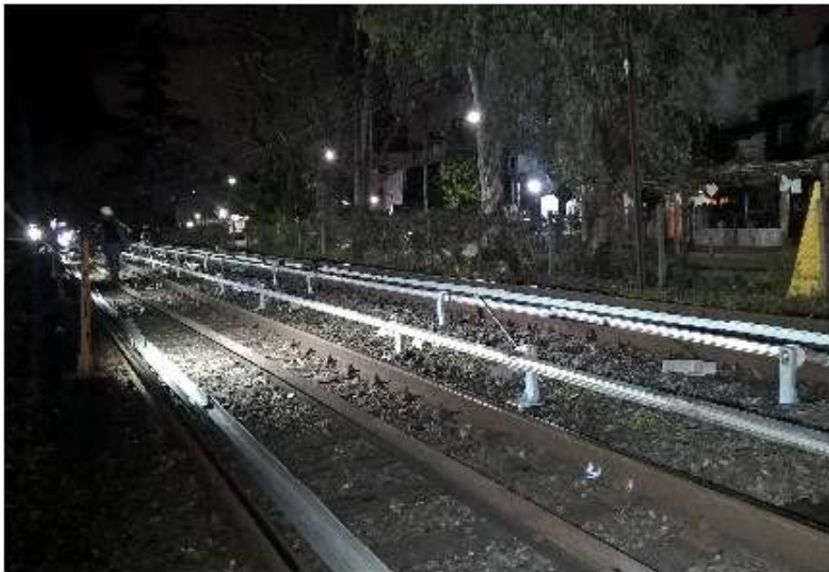
Foto 7. Sistema de Tercer Riel actual Aluminio-acero a desmontar y reinstalar
