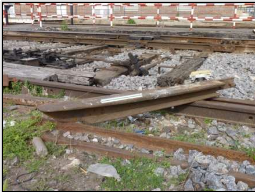
Foto 1. Rampa sin cubierta
