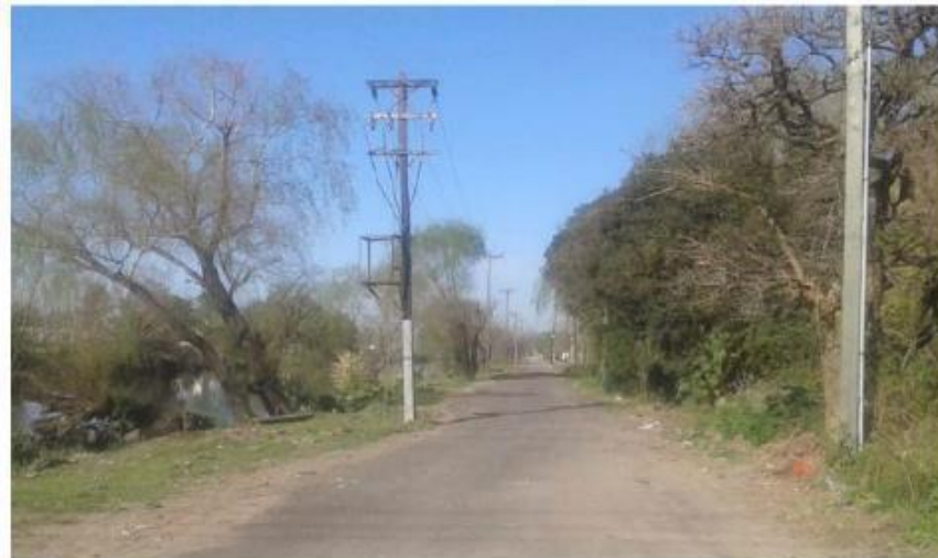
Figura N o 2 - Situación General Actual
