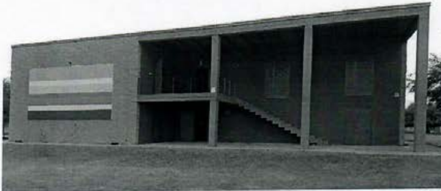
Imagen 14. Foto de la sala de extracción de COOPSOL en la Banda.
