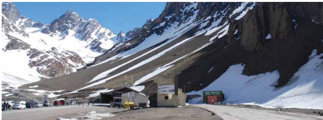
Túnel Caracoles Paso Cristo Redentor
