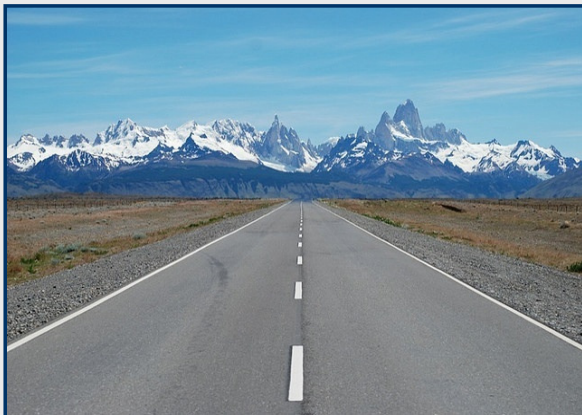
Pavimentación Ruta N° 40
