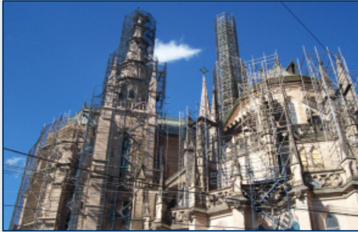
MAY-2003: inicio de la Reconstrucción
