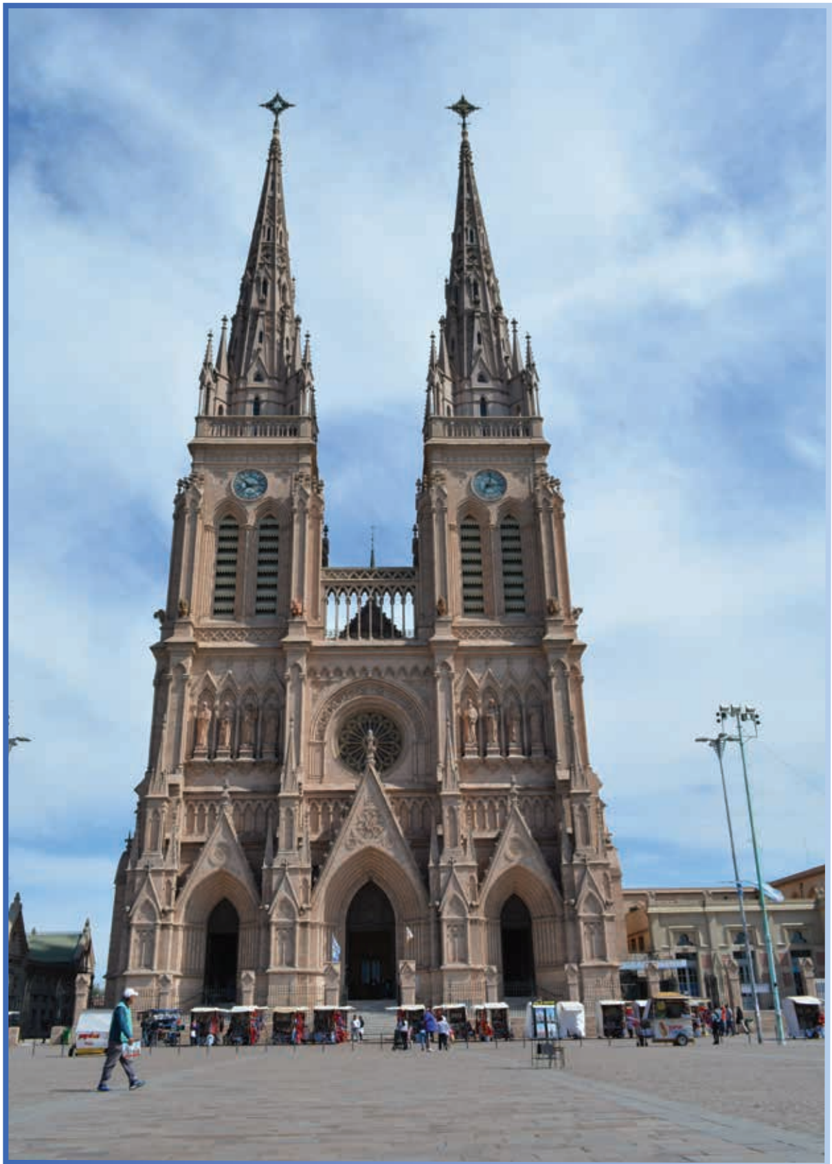
Vista del frente principal
