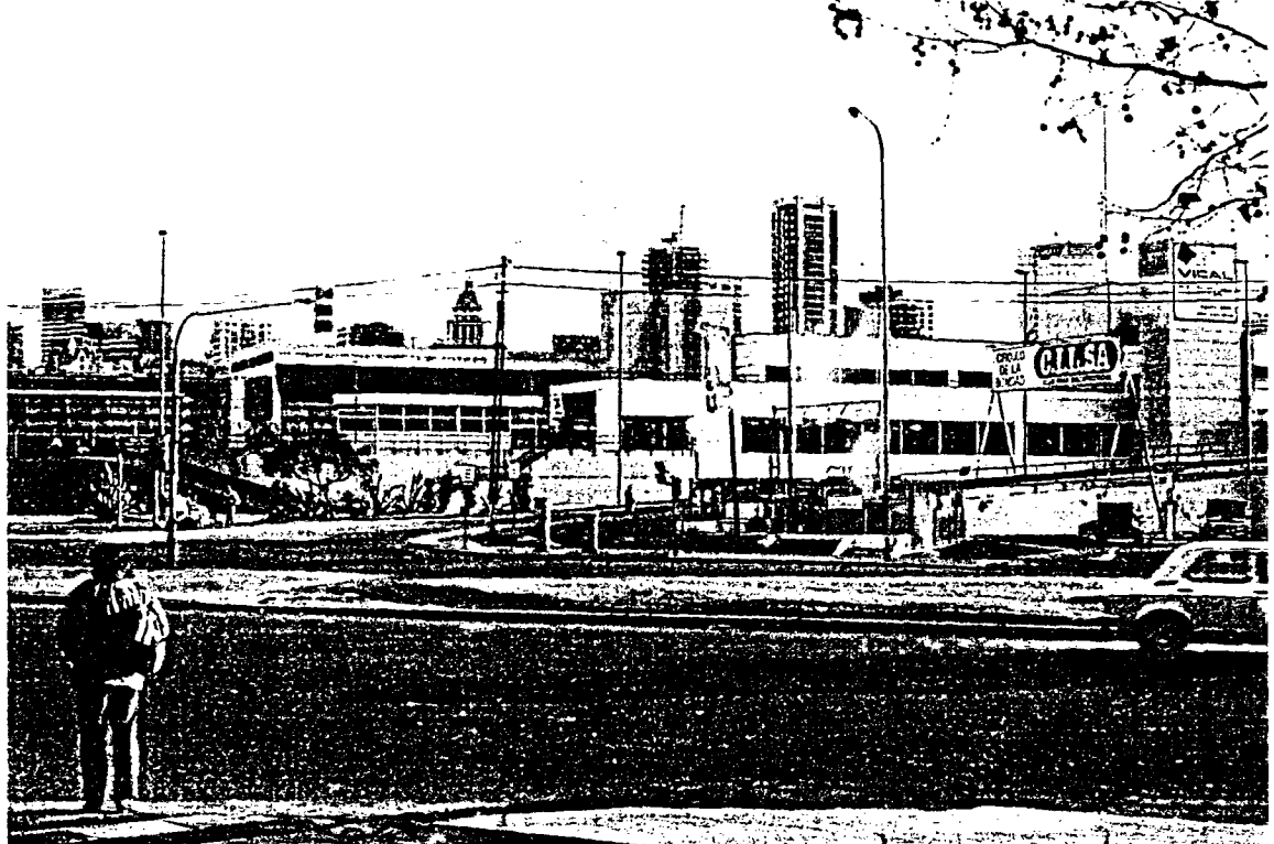
VISTA DEL ACTUAL ACCESO PRINCIPAL DESDE RETIRO.
