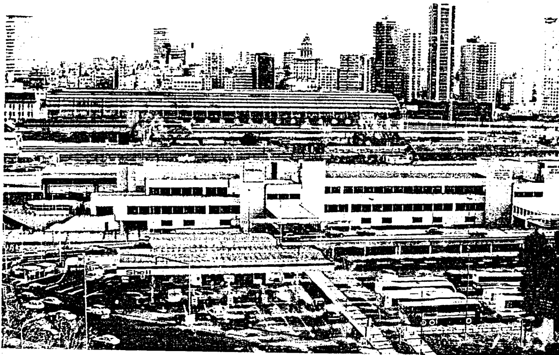
VISTA AEREA SECTORES "A" Y "B", DE FONDO EL PERFIL URBANO DEL MICROCENTRO.
