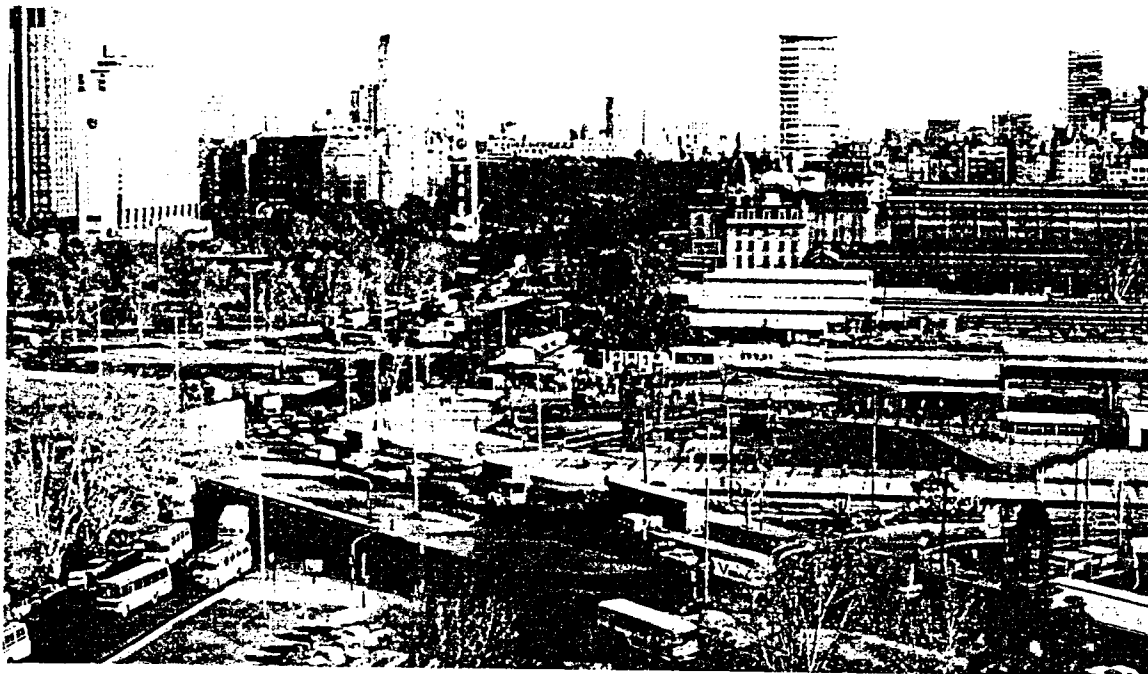
VISTA AEREA DEL EXTREMO S.E., COMO MARCO DE FONDO, ESTACION RETIRO Y PLAZA SAN MARTIN.
